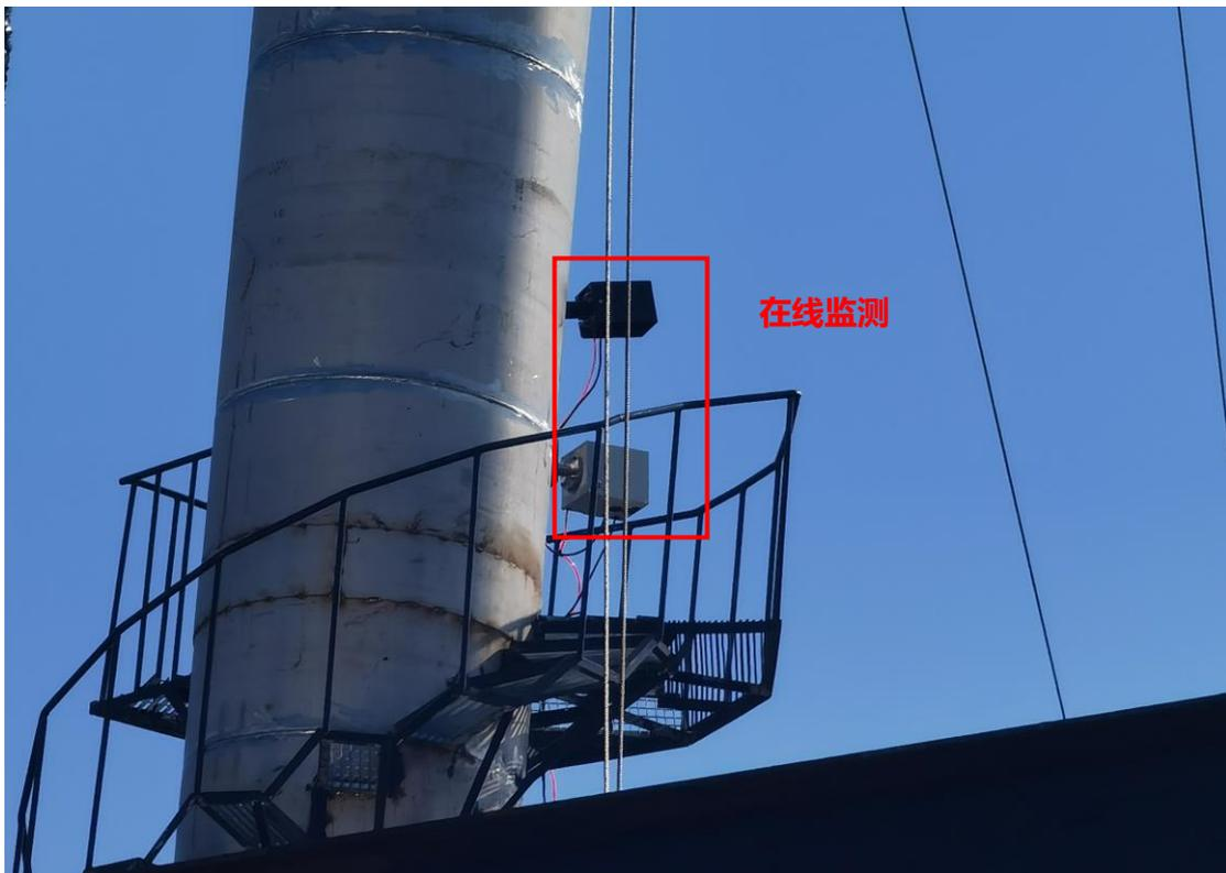
图 3-3 烟囱在线监测设备现场图
