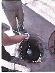
生活污水排放口
